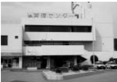
管理センター本館
