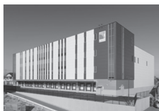
〈関東食糧(株)新物流センター「食空間創造Base」〉
