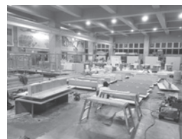
気密性能に関する研究 壁と床の取合い部の試験体製作
