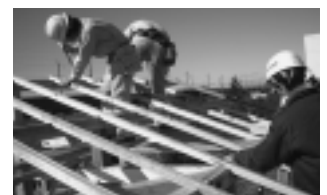
木造住宅の実技実習による技術修得
