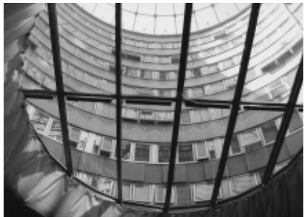
タンクの内部からみたオフィスや住居
