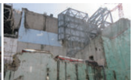
発電所内 (4号機建屋)
