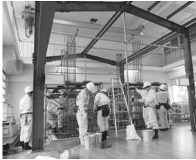
鉄骨実習の様子
