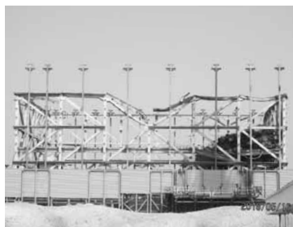
(写真⑤) 一号機建屋
