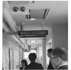
天井に設置された信号機のようなチャイムシステムと電光掲示板
