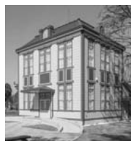
復原整備後 正面外観
