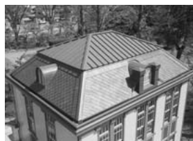
復原整備後 マンサード 屋根天然スレート葺
