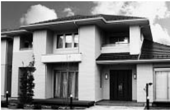
クレバリーホーム川越店住宅展示場
