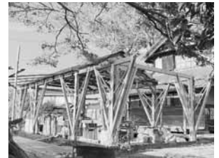
2. 加須市のカフェ屋外テラス 木造改修
