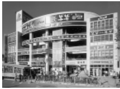
松本商会が施工・管理するふじみの駅前のパレットビル
