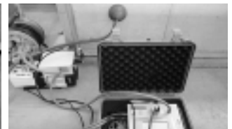
コンクリートの透気試験
