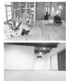
大作業+左官作業(上)、完成(下)
